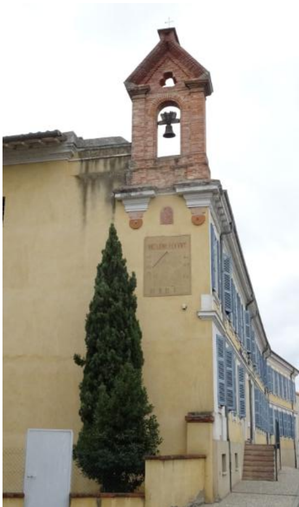
A l'entrée du village, Avenue de Toulouse
